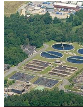
Kläranlage und Abwasserkanäle
