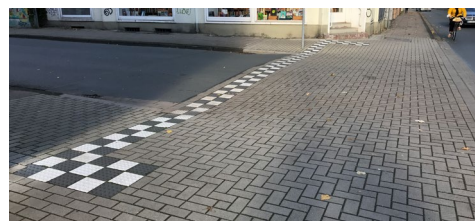
Abbildung 4-13: angehobene Gehwegüberfahrt (Musterlösung (links), in Bielefeld (rechts))
