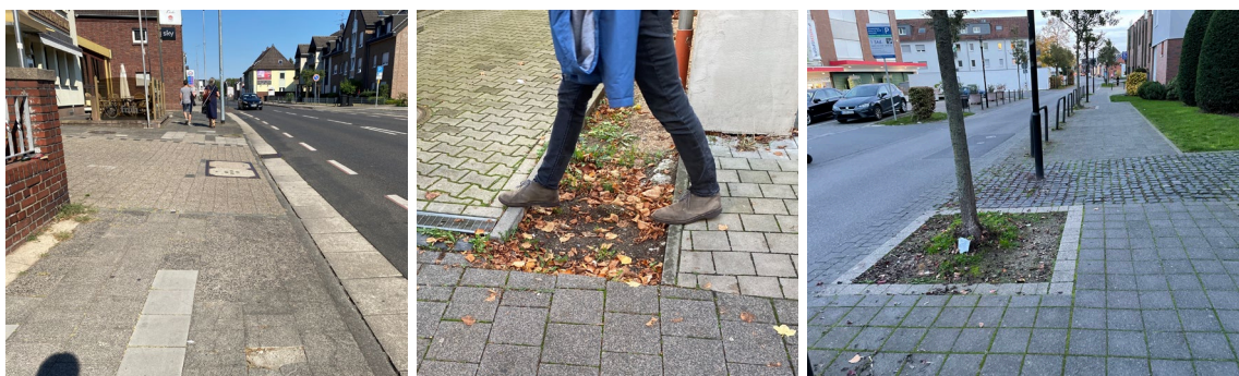
Abbildung 4-21: Nicht-barrierefreie Gehwegoberflächen in Dormagen
