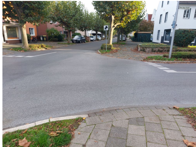
Abbildung 4-24: nicht barrierefreie Querungsstelle am Knotenpunkt Friedrich-Ebert-Straße / Vom-Stein-Straße
