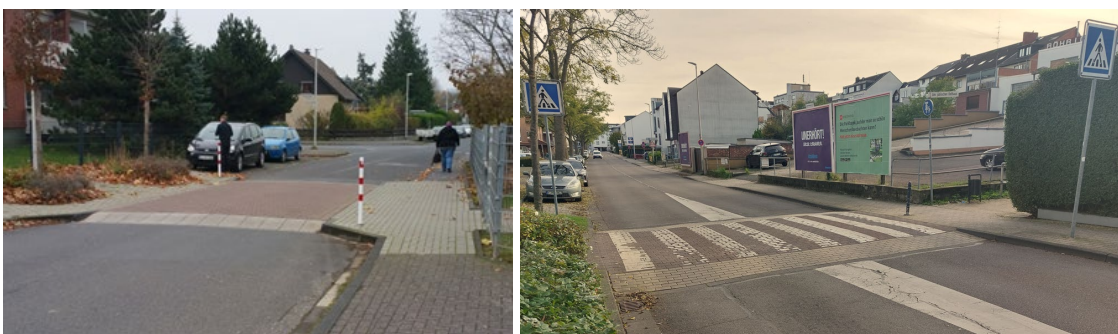
Abbildung 4-5: baulich gesicherte Querungsstellen
