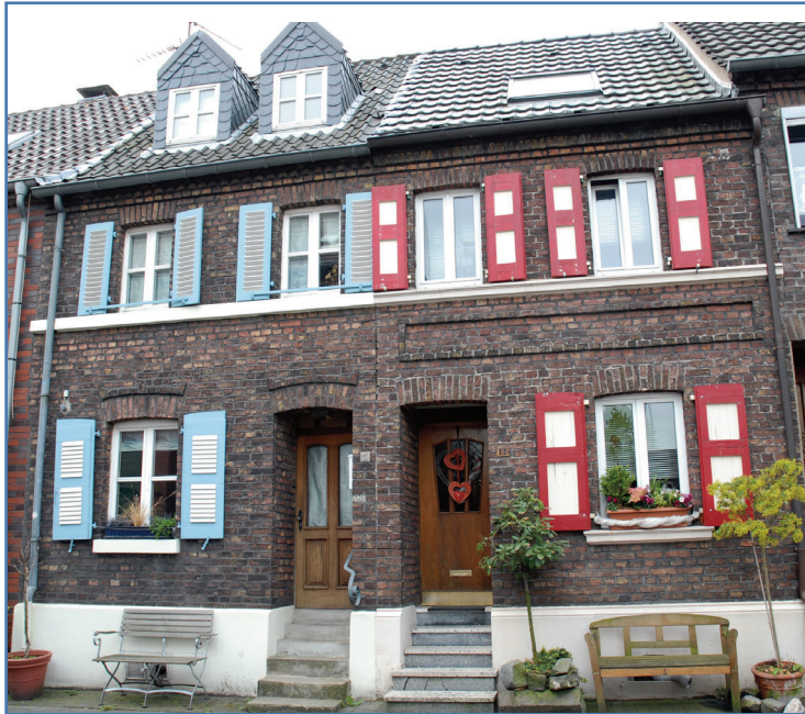
Zweigeschossiges Backsteindoppelhaus in jeweils zwei Achsen.
