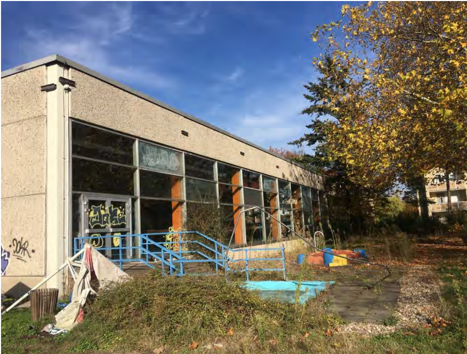
Abb. 5 Blick aus Süden auf ehemaliges Schwimmbad und Außenbereich
