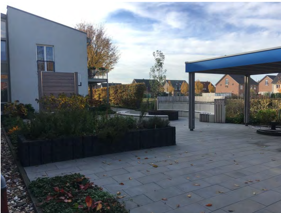
Abb. 16 Innenhof „Haus der Lebenshilfe“
