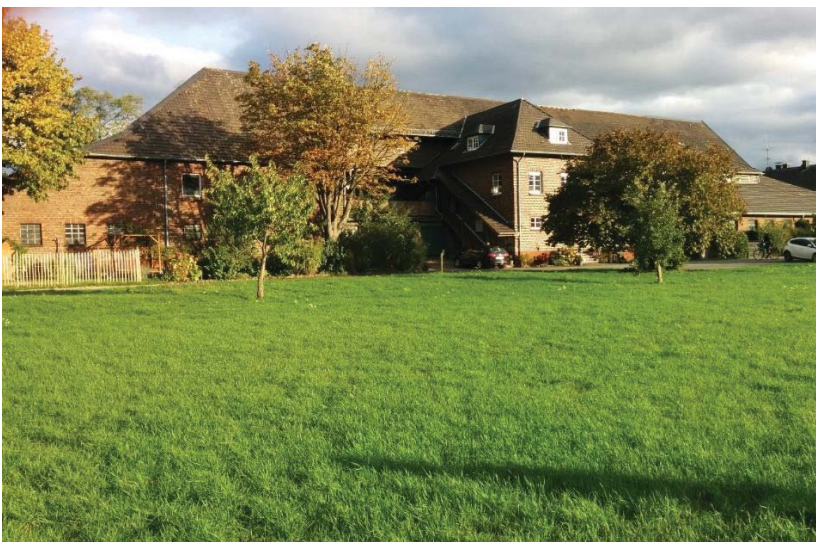
Abbildung 1: Rheinfelder Hof, Ansicht von Westen (Foto: Gelhar 10/2019)
